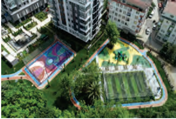
Esenevler Bölge Parkı Yeni Park Yapımı
