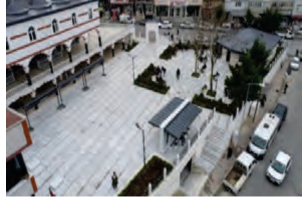
İhlamurkuyu Camii Çevre Düzenleme Çalışması
