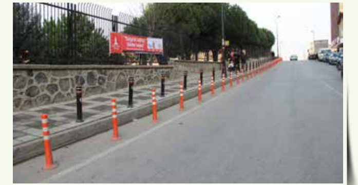
» 2013'te 1.126 adet delinatör montajı yapılmıştır.
