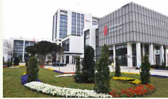
» Binanın tüm mekanik ve elektrik sistemleri tek bir merkezden kontrol edilebilmektedir.
