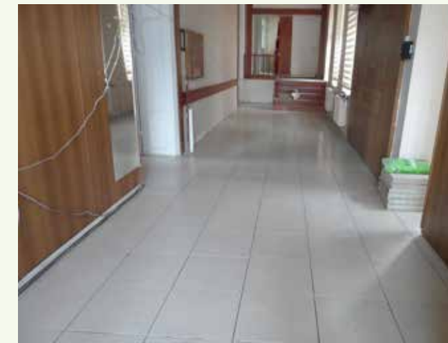
» Okulların iç mekan tadilatı
