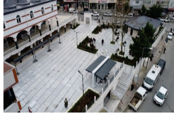
İhlamurkuyu Camii Çevre Düzenleme Çalışması
