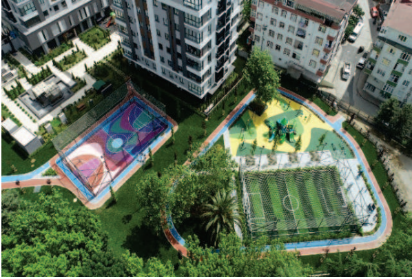
Esenevler Bölge Parkı Yeni Park Yapımı
